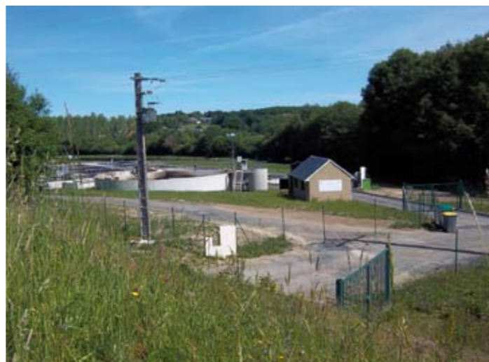
La nouvelle station d'épuration, mai 2011
